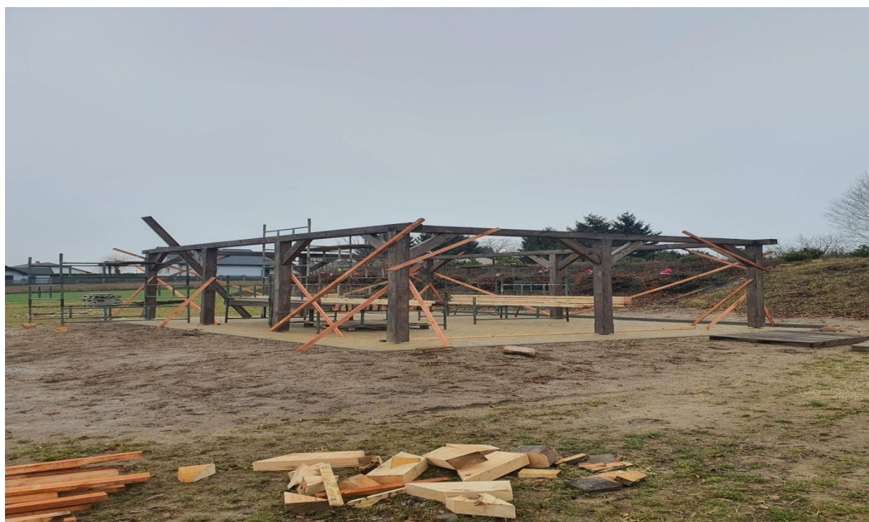
Fot.3 Początki budowy, późna jesień 2024
