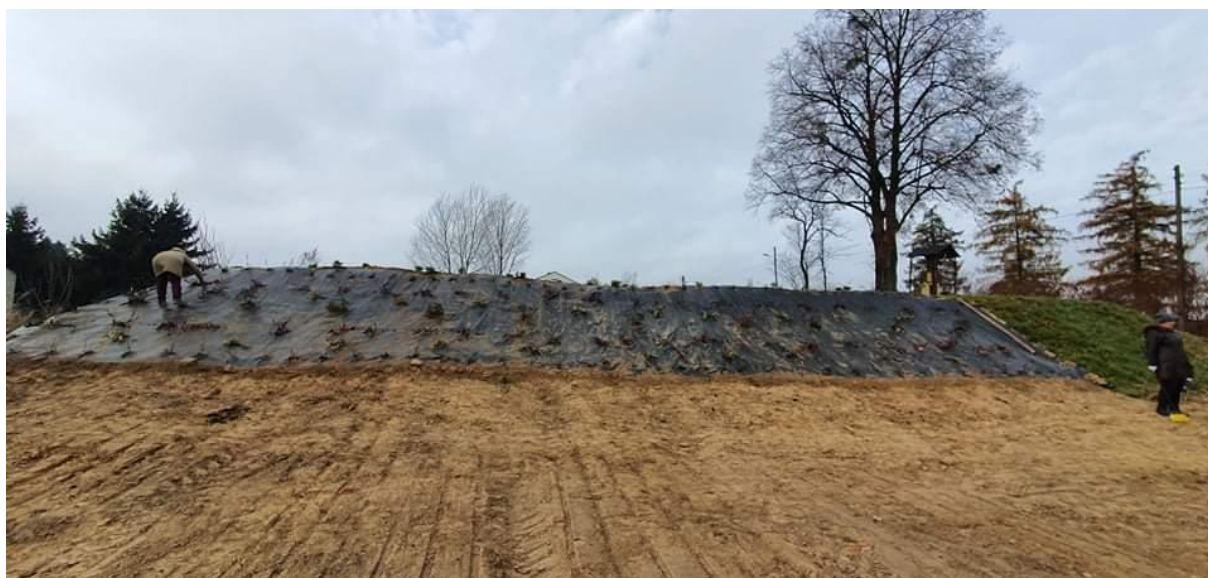
Fot.2 Prace przy tworzeniu naszego ogrodu – jesień 2021 rok
